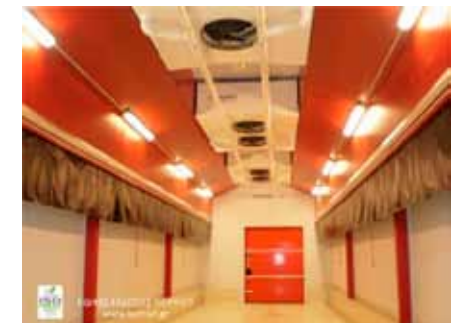
Δυναμικό προψυκτήριο προσαγωγής ψυχρού αέρα για φράουλες.
