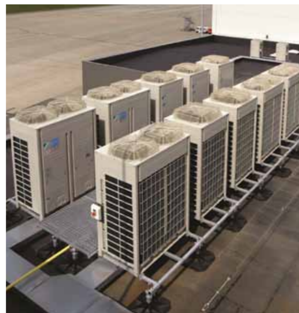
Εικόνα 1: Εγκατάσταση συστοιχίας συμπυκνωτικών μονάδων επαγγελματικής ψύξης
