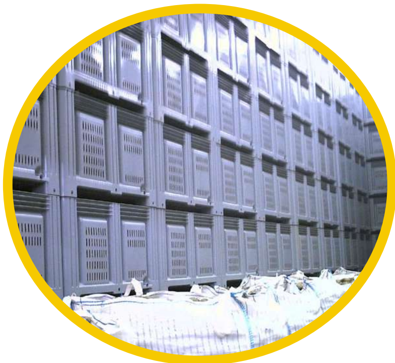
Ψυκτικός θάλαμος αποθήκευσης πατατών σε παλετοκιβώτια και τζούμπο.
