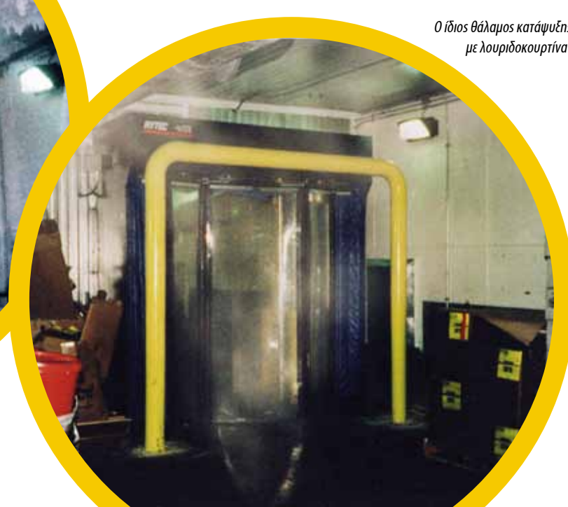
Θάλαμος κατάψυξης -25°C με λουριδοκουρτίνα χωρίς αφύγρυνση.
