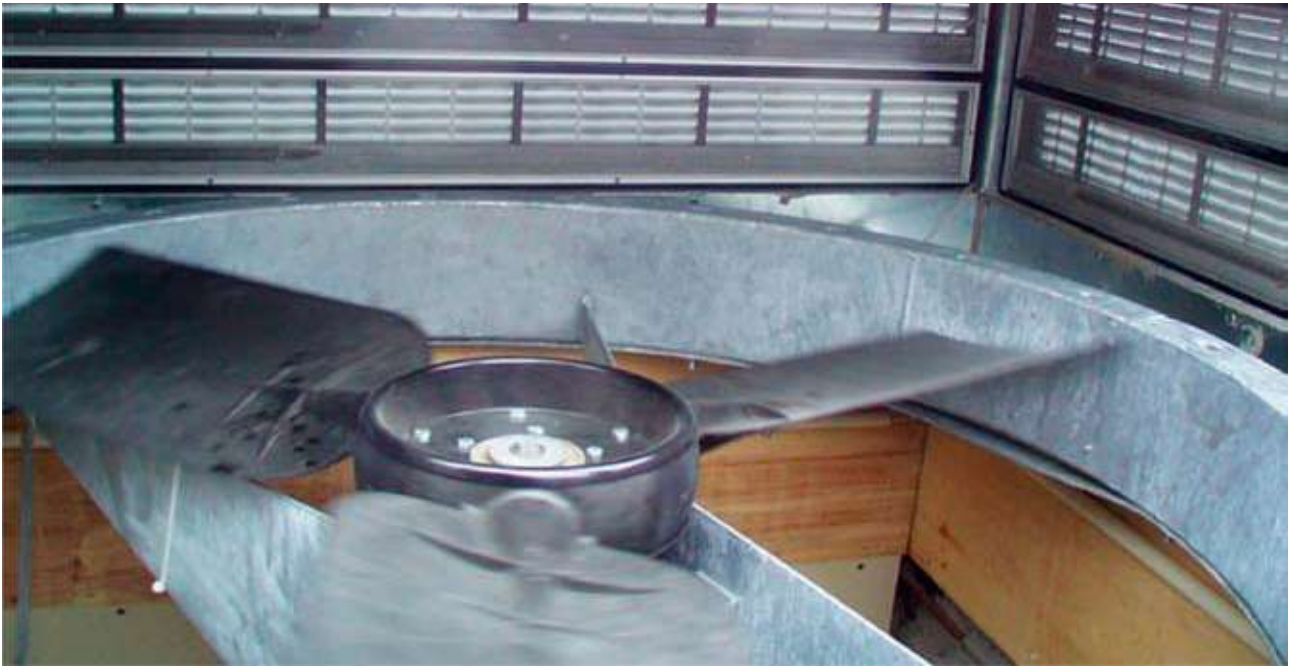
Σχήμα 6. Εξαιριστήρας στην οροφή του κτιρίου για την ενίσχυση της φυσικής ροής λόγω θερμικής άνωσης.
