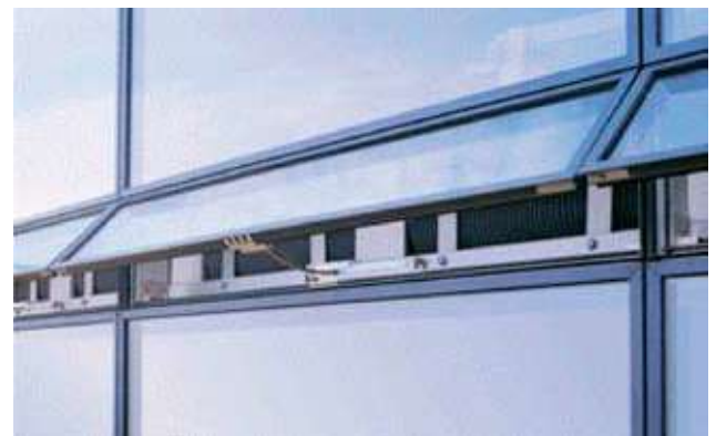
Σχήμα 4. Ανοίγματα ελέγχου φυσικής ανεμορροής σε όψη με υαλοπετάσματα.
