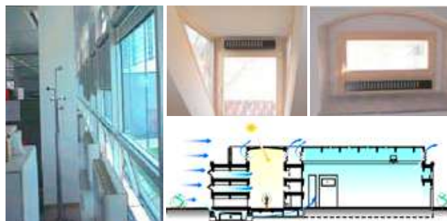
Σχήματα 7,8. (αριστερά & πάνω) Ανοίγματα αερισμού ενσωματωμένα σε κουφώματα που δημιουργούν φυσικές συνθήκες προθέρμανσης αέρα.
