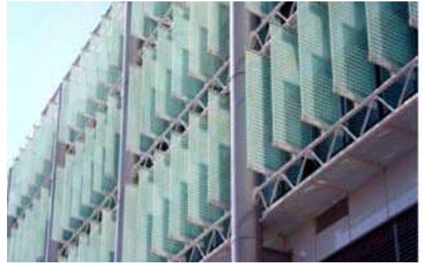
Σχήμα 1. Εξωτερικά σκίαστρα, αεραγωγοί και θυρίδες υβριδικού αερισμού στο κτίριο γραφείων της εταιρείας AVAX στην Αθήνα. Όλα τα συστήματα είναι κεντρικά ελεγχόμενα με BMS και αισθητήρες.
