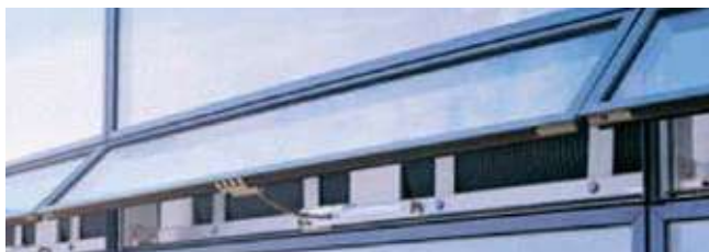
Σχήμα 6. Θυρίδες αερισμού (air inlet) σε όψη κτιρίου διαμορφωμένη με υαλοπέτασμα (curtain wall)
