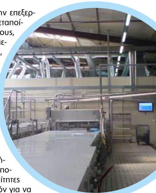
Cleanroom για τρόφιμα που κατασκεύασε η εταιρεία μας στην Ρουμανία
