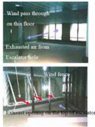
Σχήμα 7: Σχεδιασμός συστήματος φυσικού αερισμού σε πολυώροφο κτίριο πολλαπλών χρήσεων (γραφεία, αίθουσες διδασκαλίας, γυμναστήριο, βιβλιοθήκη κλπ). Μελέτη περίπτωσης στην Ιαπωνία. Χρήση των κλιμακοστασίων ως στοιχείων θερμικής άνωσης. Αξιοποίηση της ανεμοπίεσης στις όψεις του κτιρίου και είσοδος του αέρα από μηχανικά ελεγχόμενα παράθυρα. (βλ και σχήμα 9)
