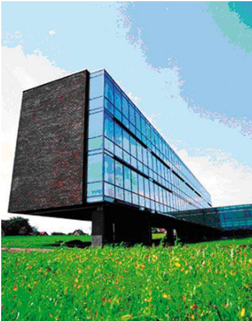
Φωτ. 1. Αερισμός κτιρίου γραφείων – εφαρμογή της αρχής του υποβοηθούμενου φυσικού αερισμού («Fan-assisted Natural Ventilation»).
