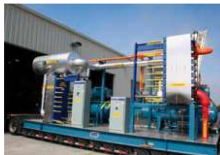
Chiller αμμωνίας 2100 KW, έτοιμο για μεταφορά (φωτ. 18 και 19)
