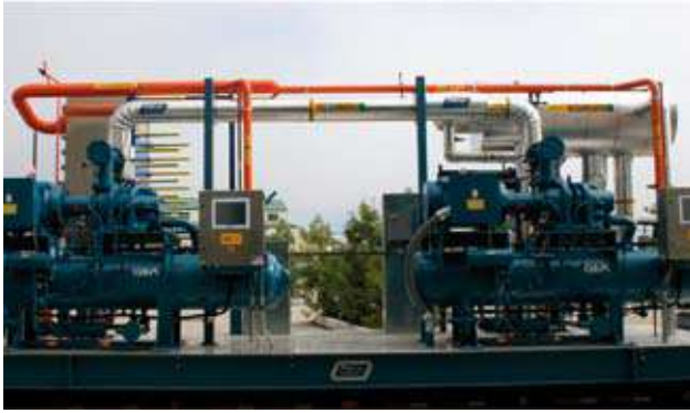
Chiller αμμωνίας τοποθετημένο στο χώρο
