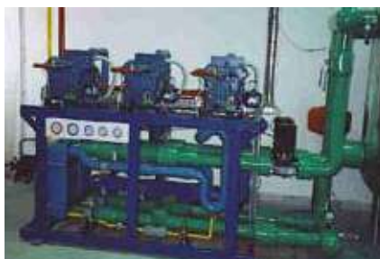
Εικόνα 1: Ψυκτικό Συγκρότημα εγκατάσταση με έμμεση ψύξη (προπιλενογλυκόλη)
