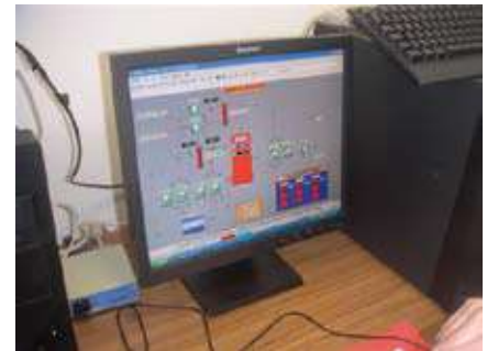
Διαχείριση εγκατάστασης μέσω υπολογιστή
