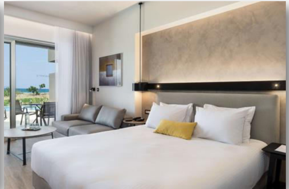
Κλιματισμός του δωματίου μέσω μονάδων Fan Coil.
